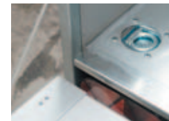
Vloeringen/vloer bekleed met alu- of staalplaat
